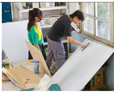
牆面測量放樣實作
