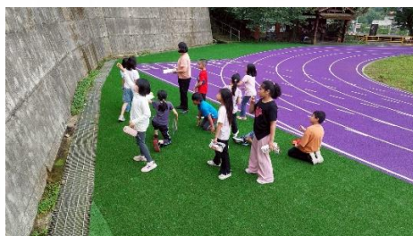
擋土牆改善優化校園安全
